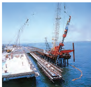
港湾を支える重防食鋼材
