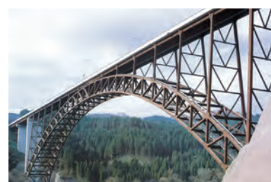
耐候性鋼適用橋梁
